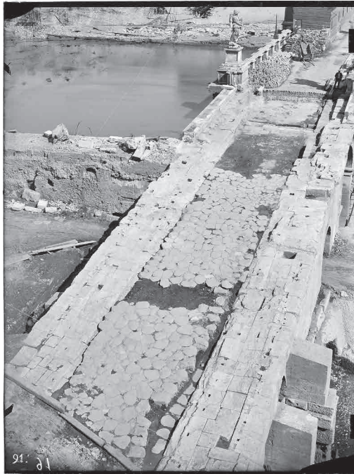
Fig. 2.20. Ponte S. Angelo, rampa sinistra con pavimentazione dell'antico Ponte Elio rinvenuta durante i lavori di arginatura del Tevere. Giuseppe Felici, 1892-1897 (Fonte: Ministero della Cultura, ICCD, Fondo Archivio Gabinetto Fotografico Nazionale, B000091).
