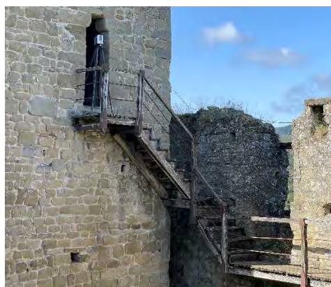
Fig. 4- Operazioni di ripresa con unità TLS all'ingresso della torre del mastio (Fantoni, 2025)
