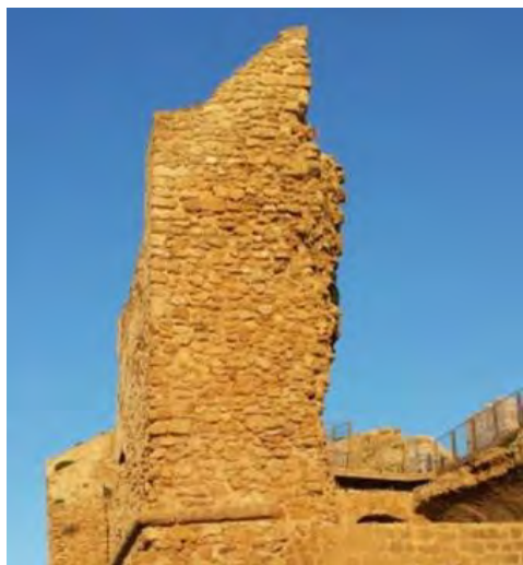
Fig. 10- Perdita di forma per caduta
