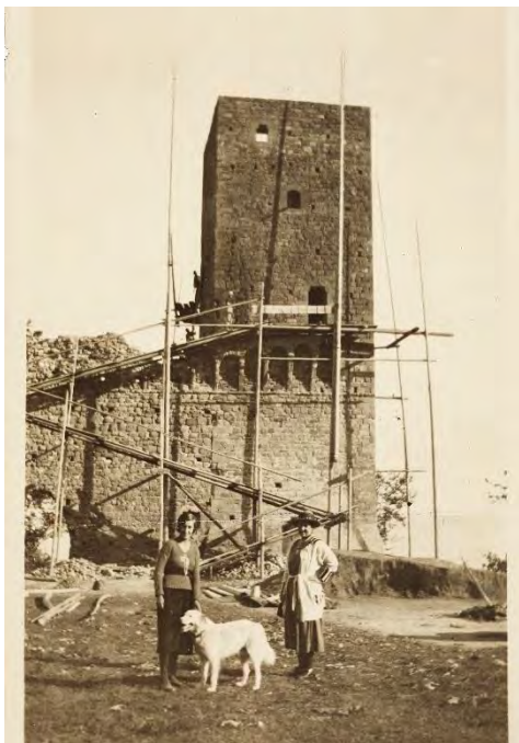
Fig. 3- La Torre delle Prigioni durante i primi lavori di restauro (Istituto Centrale per il Catalogo e la Documentazione, 1930 circa)
