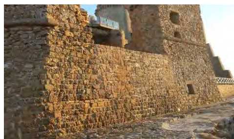
Fig. 8- La tessitura a conci del bastione esterno
