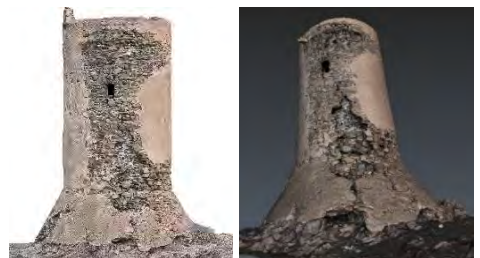
Figs. 6a, 6b- Ortofotoplano del alzado Sur y modelo 3D donde se observa la importante pérdida de volumen de masa del cuerpo de la torre (aprox. 40 cm).
