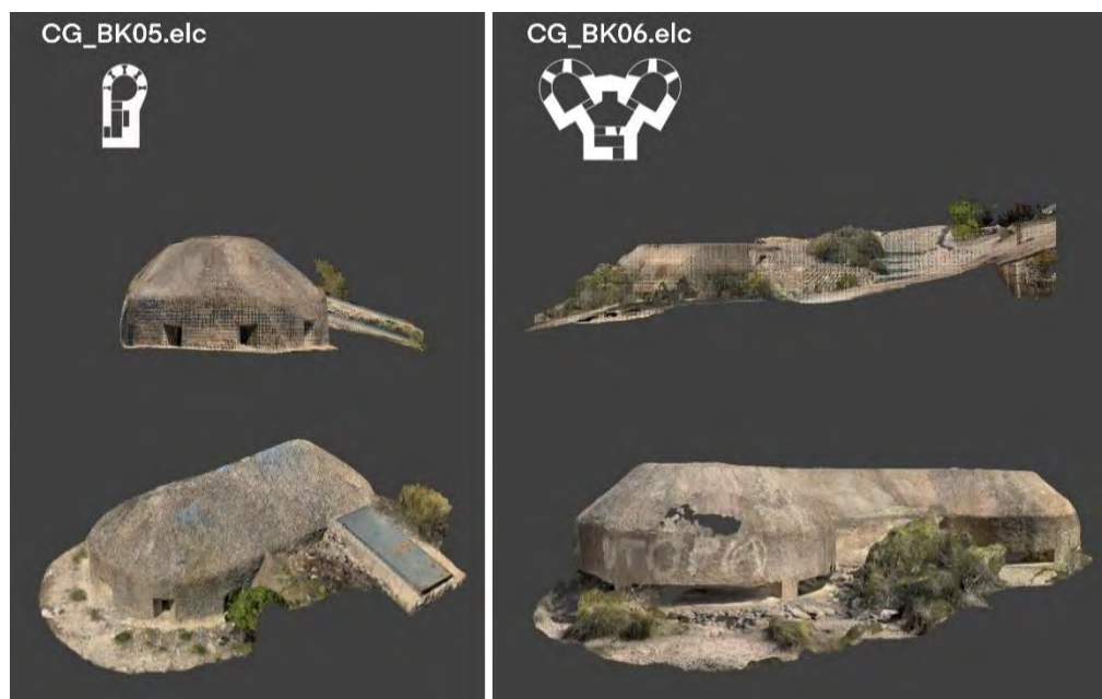
Fig. 5- Levantamientos fotogramétricos de los búnkeres BK05.elc y BK06.elc. El BK.05 (izq.) es un pequeño búnker enterrado tipo casamata de un seno al que se accede por una escotilla y escalera que desciende, previsto para 1 o 2 soldados con fusil. El BK06 (dch.) está compuesto por un búnker de dos senos dispuestos radialmente, al que se accede por una galería posterior, equipados cada uno con mesa para ametralladora, barriendo ambos más de 180° del campo de tiro (fuente: G. Sanna, 2025)
