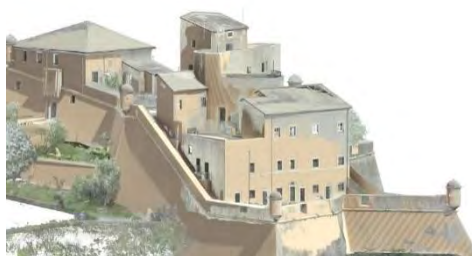
Fig. 4- Modello BIM sovrapposto alla nuvola di punti di Forte San Giovanni (elaborazione grafica di FABRICA Società Cooperativa, 2022)
