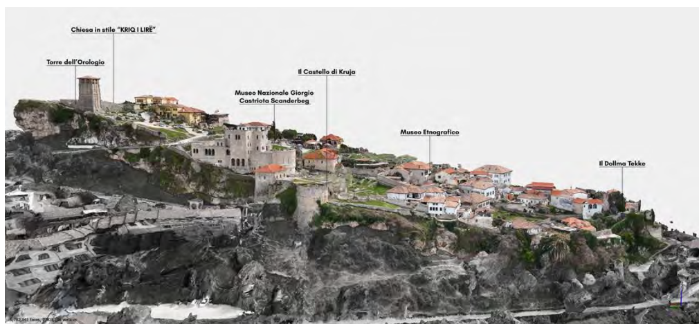
Fig. 6- Mesh texturizzata del lato nord-ovest del Castello di Kruja con individuazione dei capisaldi (elaborazioni e restituzione grafica di Angelo De Cicco)
