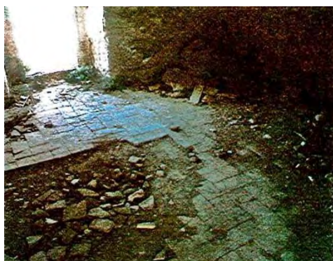
Fig. 4-Planta baja de la torre en 2014 (foto autor)
