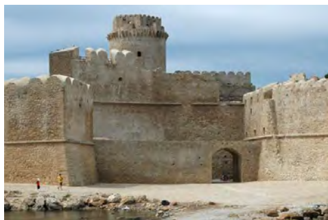
Fig. 6- I bastioni angolari sul fronte Nord
