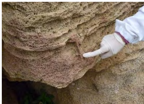
Fig. 9- Superfici ossidate (zona posteriore)
