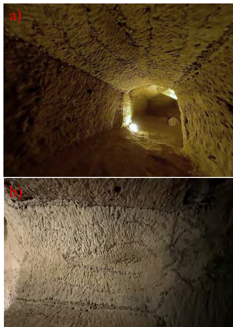
Fig. 2a-b- Ambiente ipogeo collocato al di sotto del Castellare: a) alternanza di sabbie e ghiaie sulla volta b) motivo concentrico (elaborazione grafica degli autori, 2025)
