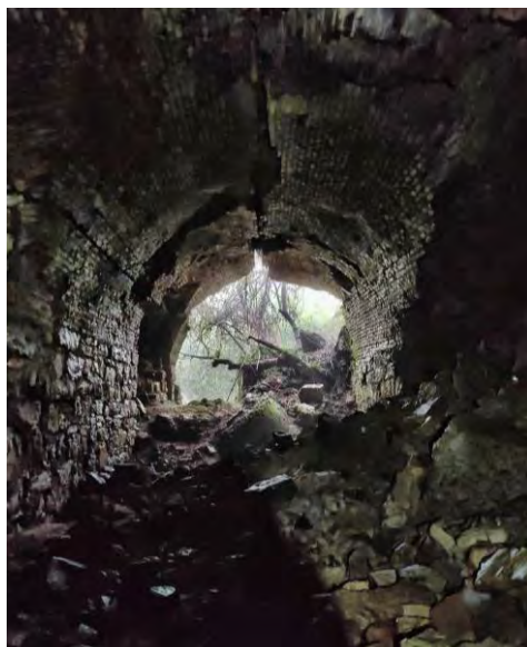
Fig. 2- Vista di uno degli interni con gravi lesioni strutturali nella volta (Marzo 2025)
