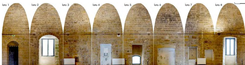
Fig. 6- Faro di Torre San Giovanni, Ugento (Le). Rilievo fotogrammetrico: sala ottagonale (Amb. II)
