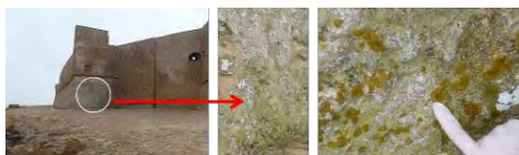
Fig. 12- Licheni sui bastioni, lato anteriore
