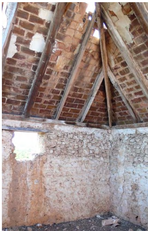
Fig. 5- Estado de la cubierta en 2016 (foto autor)
