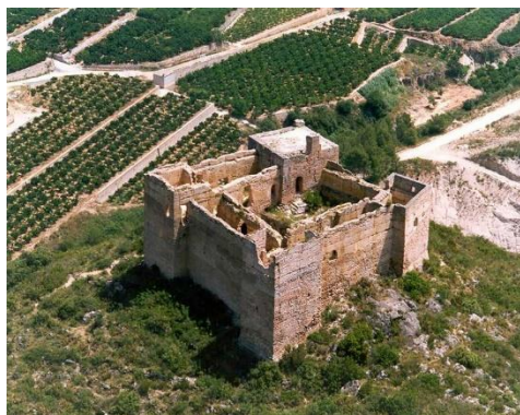
Fig. 7- Vista aérea del emplazamiento del Castillo de Forna (IGPCV consultado el 04/10/2025 en web Patrimonio GVA)
