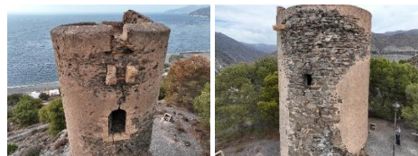
Figs. 4a, 4b- Imagen de caras norte (a) y sur (b) de torre Melicena con grieta vertical que se prolonga por el lateral Este
