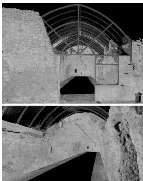
Fig. 3- Viste prospettiche della nuvola di punti delle scuderie del castello (elaborazioni grafiche degli autori, 2025)
