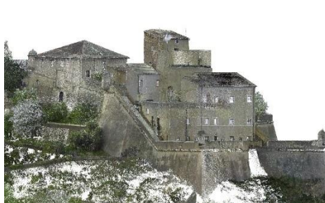
Fig. 3- La nuvola di punti di Forte San Giovanni dopo la registrazione (elaborazione grafica di FABRICA Società Cooperativa, 2022)
