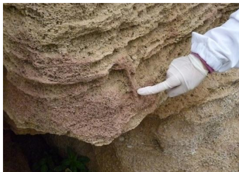
Fig. 9- Superfici ossidate (zona posteriore)
