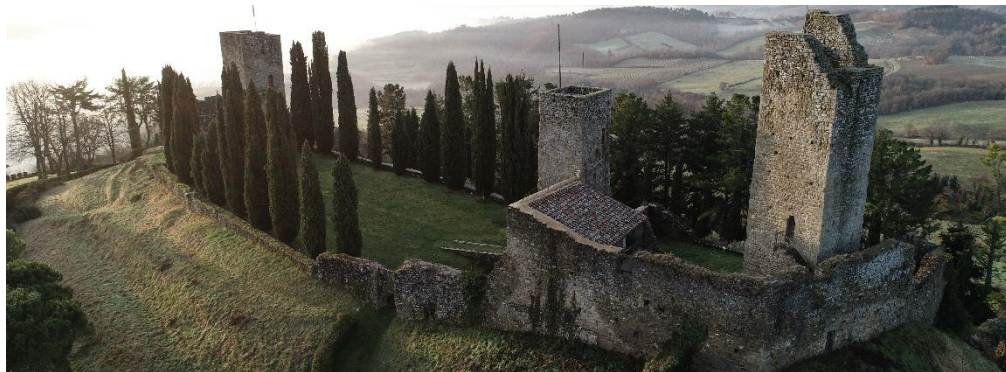
Fig. 9- Fotografia aerea da drone del fronte nord del castello (Fantoni, 2025)
