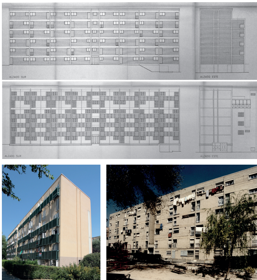
Fig. 3. Bloque linear, estados inicial y rehabilitado (1994, 2020) / Linear block, initial and rehabilitated state (1994, 2020) (©Archivo CREA Arquitectos y Noelia Cervero Sánchez)
